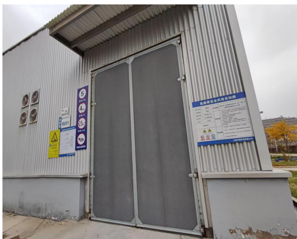
废油及废油桶贮存库
